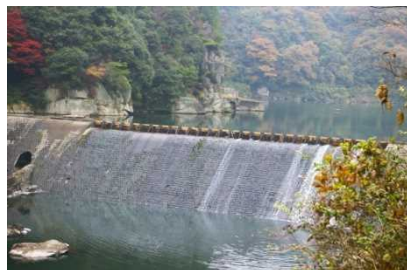
大河原堰堤(発電所の1キロ上流)にある
