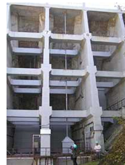
コンクリートを窓枠のように使用したバットレス構造
